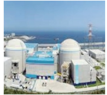
발전소 설비에 산소 공급
